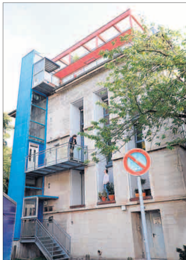
Wohnen im Bunker: Wie hier in Eilbek entdecken immer mehr Individualisten die Schutzräume auch als Wohnhaus. Allein der Einbau der Fenster hat 20.000 Euro gekostet.
